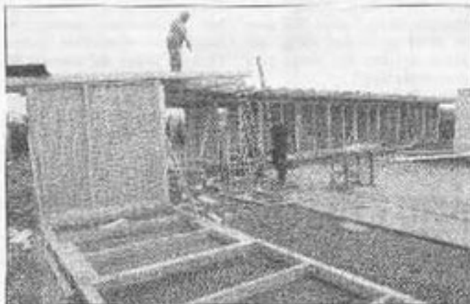
Die Bauarbeiten haben begonnen. FOTO: camera900.de
