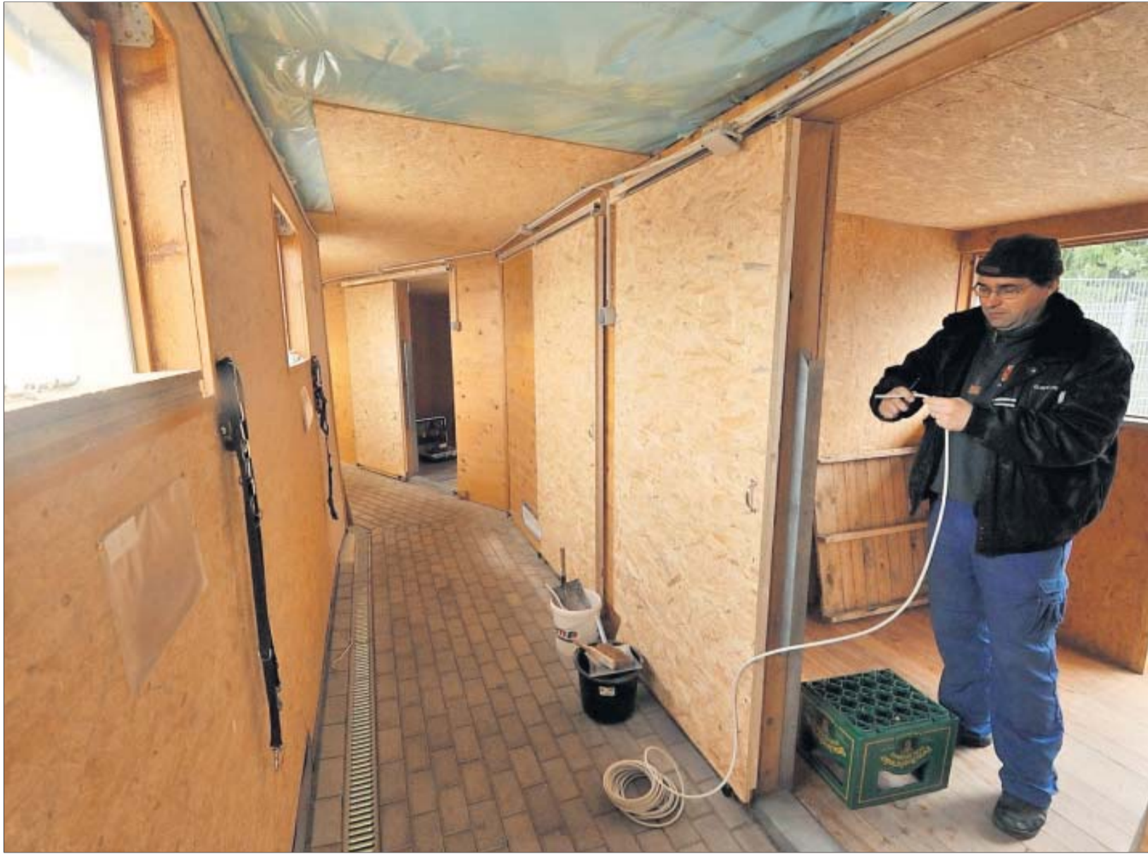
Die Dämmung der Hundeanlage ist eine der ersten Maßnahmen bei der Sanierung des Tierheims.
